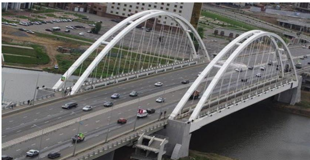
Рисунок 1 – Мост «Архар» в г. Астана
